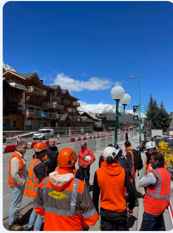
3e réunion de chantier réunissant les entreprises Profil'Etudes, Colas, Citeos, Gravier TP, Perino Bordone, Espaces Verts du Dauphiné, le Département de l'Isère, le SACO, ainsi que la commune avec Philippe Arnol, 5e adjoint délégué aux travaux.
