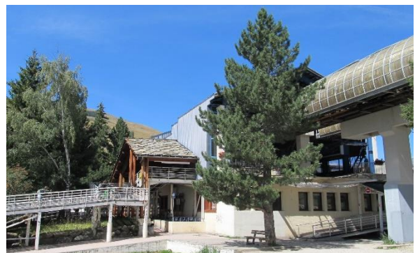
escalier d'accès depuis l'attente
