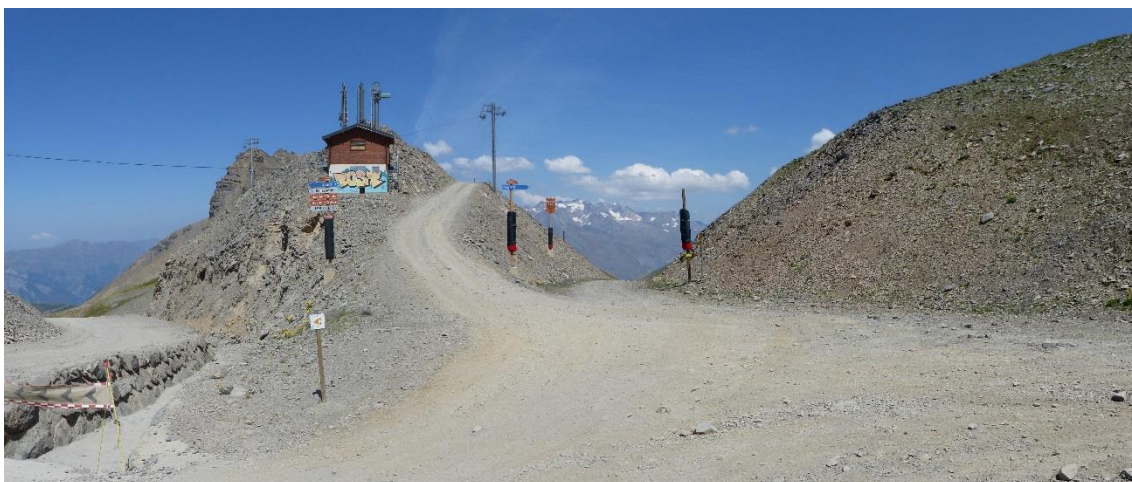
Vue sur l'extrémité amont de la piste de la Fée 1 vouée à être élargie, très minérale avec de nombreux éléments perturbateurs (signalétique, équipements techniques...)
