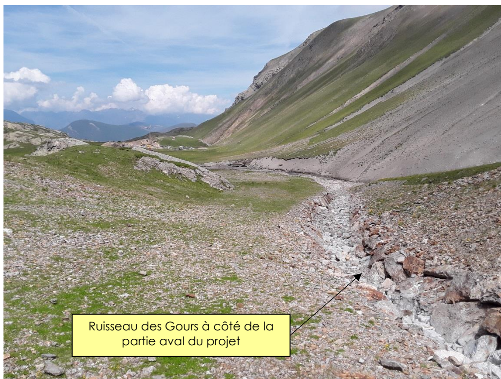
Partie aval de la piste de la Fée 1 longeant le ruisseau des Gours
