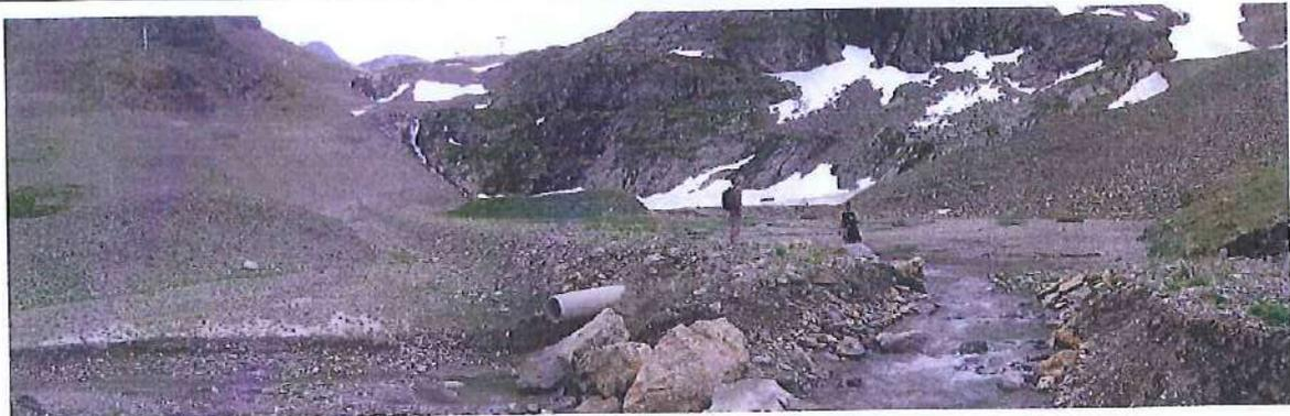
*Détail de la partie est de l'ombilic, le torrent en eau a créé une brèche dans le merlon*
