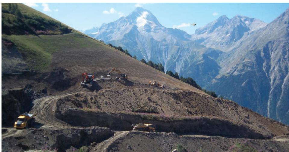
Les tranchées nécessaires à la mise en place des conduites (généralement d'une largeur inférieure à 2 mètres pour contenir 1 canalisation fonte pour l'eau, 1 canalisation PEHD pour l'air, 1 fourreau pour l'alimentation électrique BT, 1 fourreau pour le système de communication) seront réalisées à la pelle mécanique en bordure de pistes terrassées et pour certaines reverdies artificiellement.
