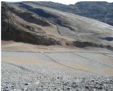
Figure 24 : Terrassements et canaux sur le bassin versant de la retenue - 27 juillet 2009
