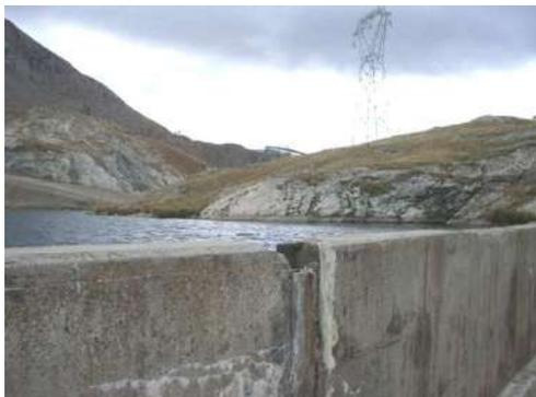
Figure 36 : la digue du Grand Plan du Sautet réduit les écoulements superficiels lorsque l'ouvrage n'est pas rempli (05/10/09)
