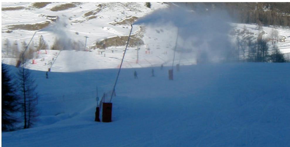
Les enneigeurs seront alimentés en air et en eau par des conduites enterrées dans des tranchées de l’ordre de 1,2 à 2 m de profondeur selon les circonstances locales.
