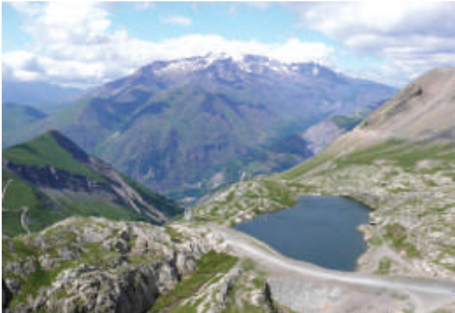
La réserve du Grand Plan du Sautet — capacité de 200 000 m<sup>3</sup> — sert à la fois à limiter le battement de la nappe du Grand Nord qui assure en hiver un complément du système d'Alimentation en Eau Potable (AEP) de la Selle et à approvisionner une unité de production de neige de culture.
