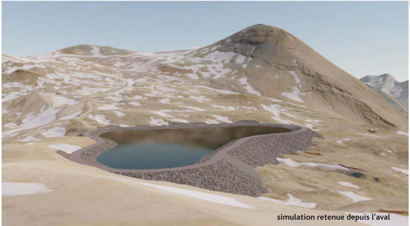
Il sera prévu un redan de 1 m de hauteur au sein du rocher afin de bien caler le pied de la digue. Cette dernière sera mise en œuvre à l'aide de matériaux de minage (0/400) issus du terrassement de la cuvette par couche de 0,60 m d'épaisseur soigneusement compactée.
