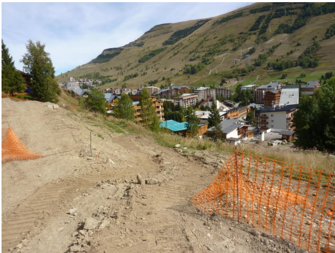
Photographie du site du projet, prise le 24 septembre 2018. Sur la gauche vue partielle de la résidence « SUPER VENOSC », sur le bas ce qui reste de la gare de départ du télésiège.
