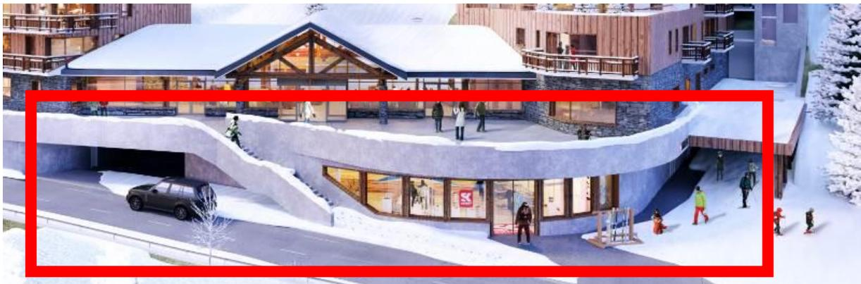
L'accès en voiture depuis le centre et la topographie du terrain permettent d'entrer naturellement et facilement dans le parking semi-enterré regroupant la majorité du stationnement véhicule et les locaux techniques.
